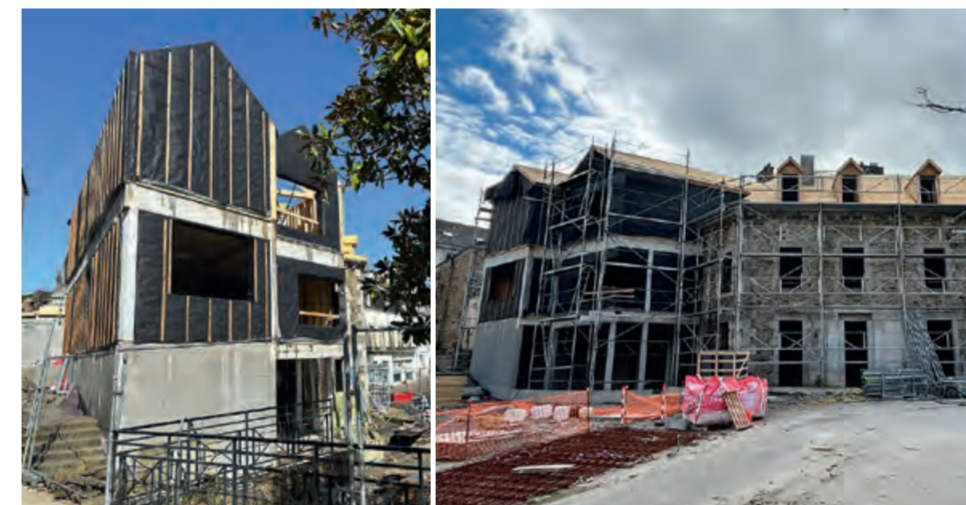
Avril 2024 : pose des façades de l'extension.
