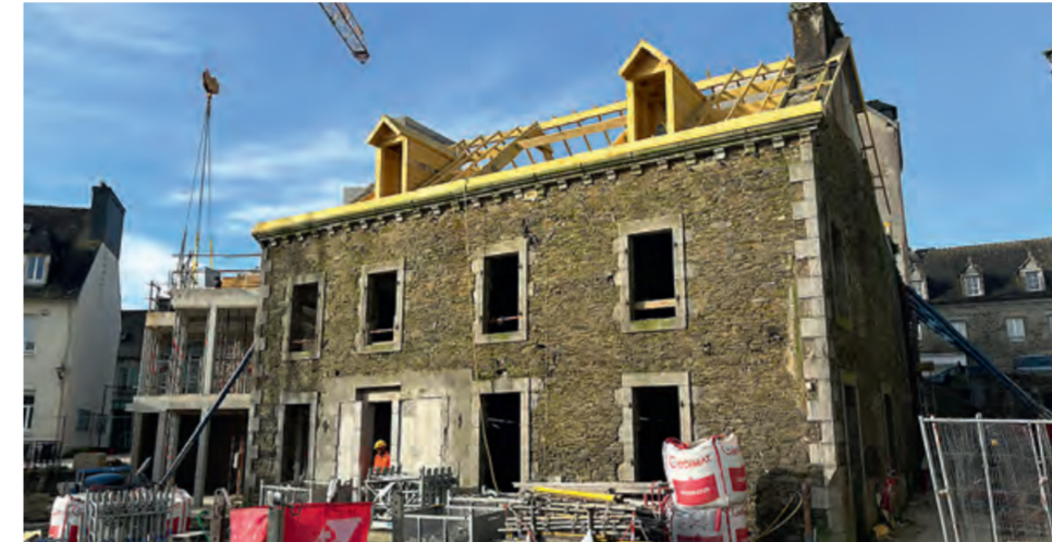
Mars 2024 : début des travaux de charpente sur les parties anciennes.
